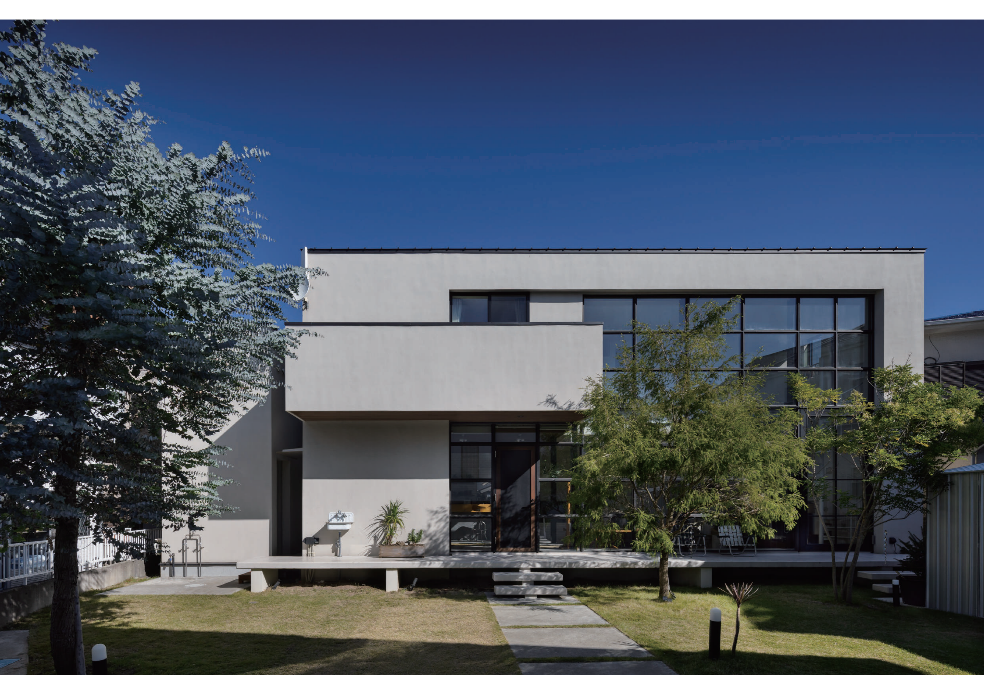
△南側からの外観 2階まで連続した格子窓が特徴
